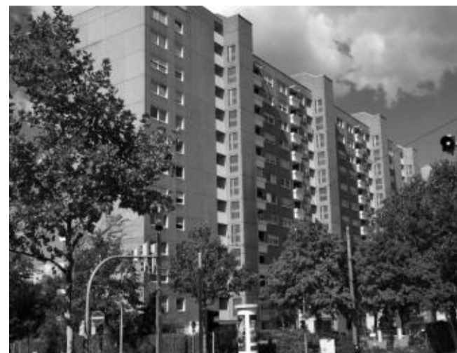
Ehemalige Postwohnungen in der Bartningstrasse
